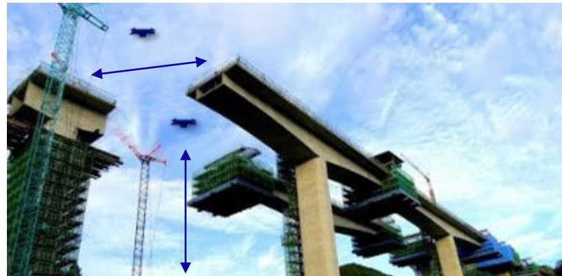
建設現場での資機材の輸送
